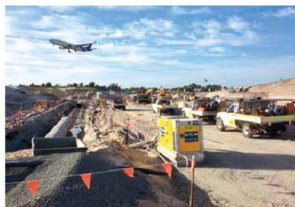
Rudolf je radio i na ovom gradilištu u Australiji
